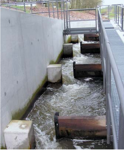
Abb. 5 Schlitzpass als Fischaufstiegshilfe an Querbauwerken
