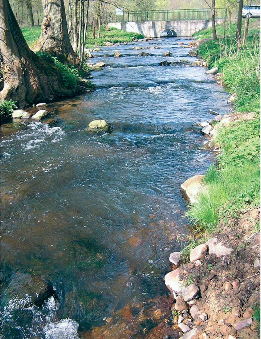
Abb. 7 Fischaufstiegsanlage an der Löcknitz
